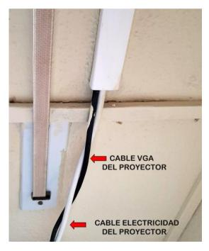
En este caso, el cable negro deberíamos conectarlo al puerto VGA del portátil y el cable blanco debe ir a un enchufe de la clase, ya que es el que aporta la corriente eléctrica. Para distinguir el cable VGA que baja del proyector con el resto de cables VGA podemos fijarnos en que, normalmente, el cable del proyector es más ancho que los otros.
